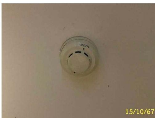
เครื่องตรวจจับควัน/หัวกระจายน้ำดับเพลิง อัตโนมัติ
